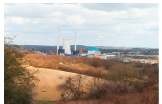
Die Alternative in Sichtweite: Kraftwerk Ens Dorf
